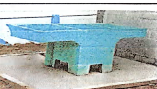
Foto 5: instalación de pila
