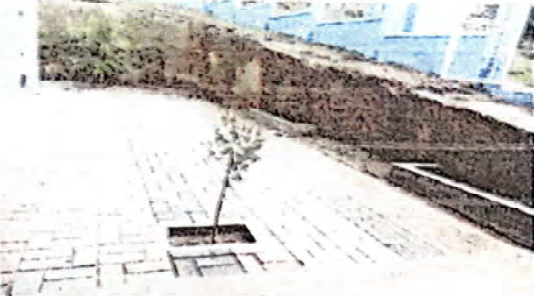
Foto 6: reparación de piso de concreto.
